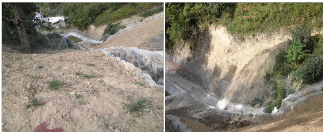
Fotografías nº3 y 4.- Bajantes escalonadas ejecutadas en el año 2013 en la parte inferior del relleno.
